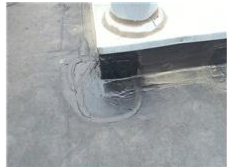
09R - Fan/Vent Repaired Areas:1
